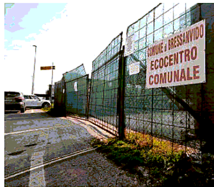
La struttura. Lavori in corso all'ecocentro di Bressanvido. B.LLO
