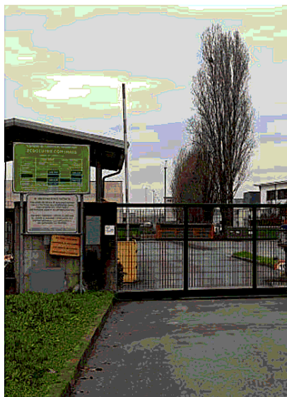
La rivoluzione Sono in partenza i lavori all'ecocentro di via Ca' Marzare M.M.
